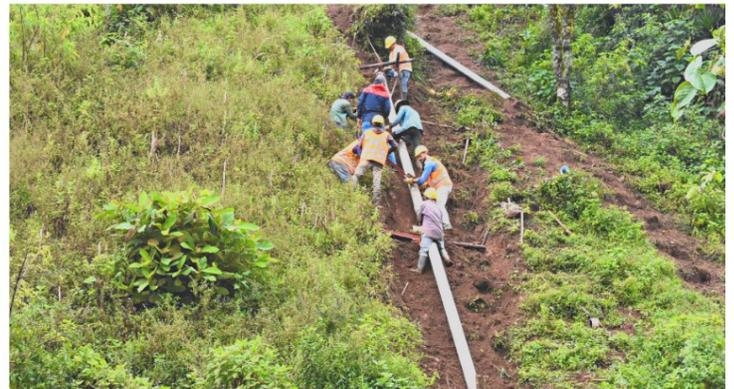
Reparaciones en el sistema de agua Celaque-Magueyalel en el occidente de Honduras donde se cambió la tubería de plástico con tubería de hierro galvanizado por la fuerte presión del agua en varias secciones de la línea de conducción. Estas reparaciones continuarán en el 2022.
