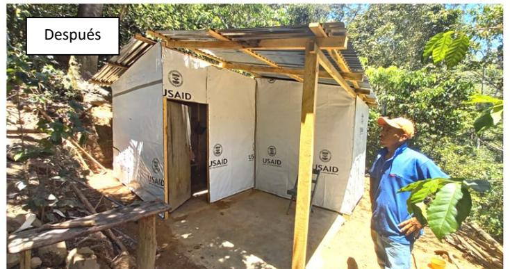
Fotos del antes y después de reparaciones de vivienda en la comunidad de Jardines que incluye cimentación nueva, columnas de madera, lona de plástico y un nuevo techo.
