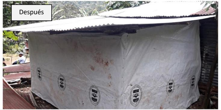
Reparaciones de viviendas incluye cambiar láminas viejas y oxidadas utilizadas como paredes de casa con columnas de madera y lona de plástico.
