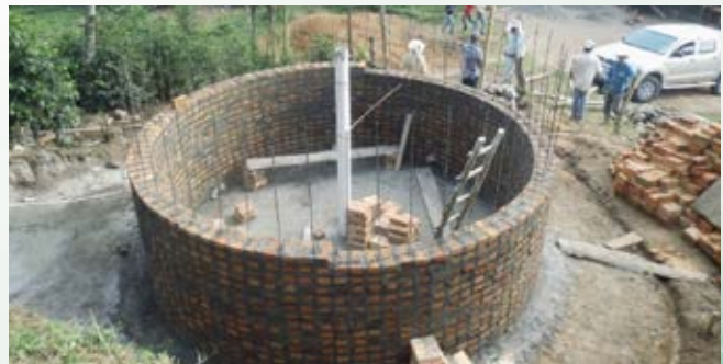
Construction of community water systems. / Construcción de sistemas de agua comunitarios.
